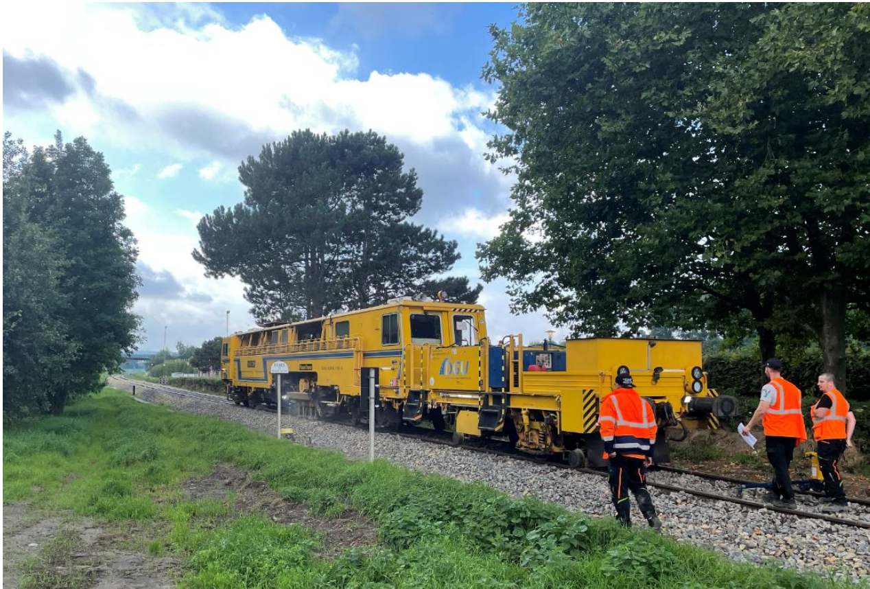
Schotterstopfmaschine bei Weisweiler, 19.09.2021, Quelle: EVS
