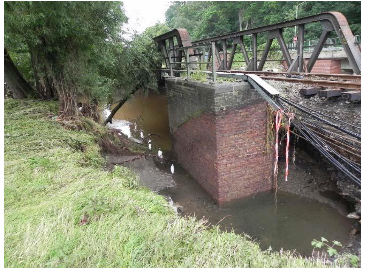
Eisenbahnbrücke über die Inde, Quelle: EVS
