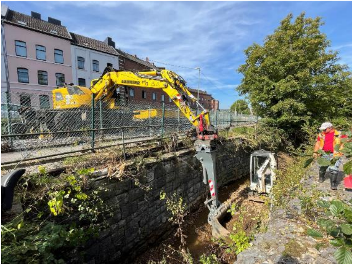
Räumarbeiten bei Stolberg-Schneidmühle, 22.09.2021, Quelle: EVS
