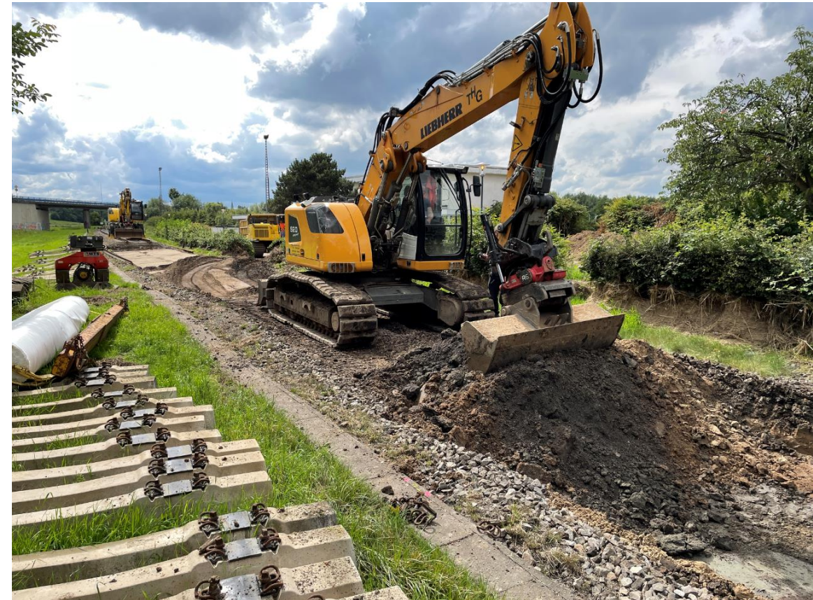
Erneuerung Oberbau, 20.09.2021, Quelle: EVS
