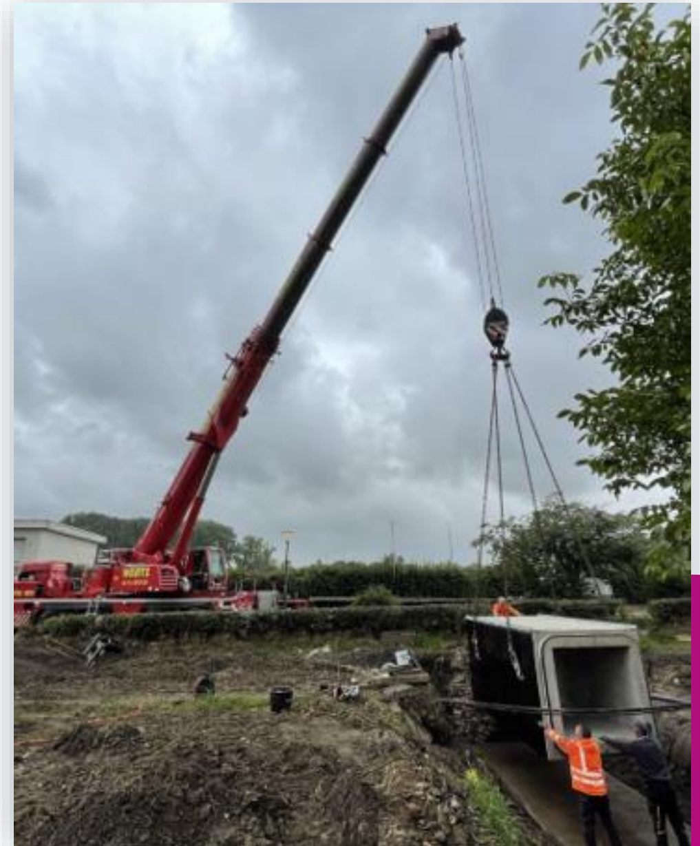
Erneuerung Durchlass Stadionstraße, Eschweiler, 26.08.2021, Quelle: EVS
