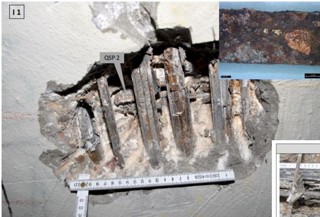
Brückenunterseite Feld 4: I1
