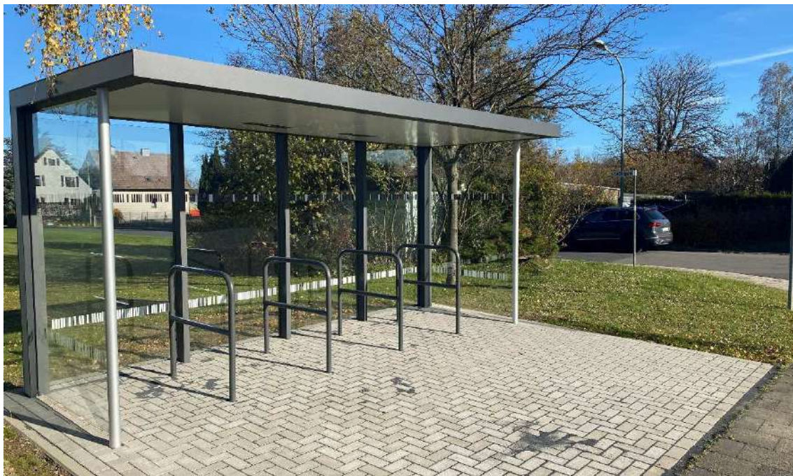
Abb. 4.1-1 Beispielhafte Darstellung von überdachten Radabstellanlagen, Kreis Düren (Eigene Aufnahme)
